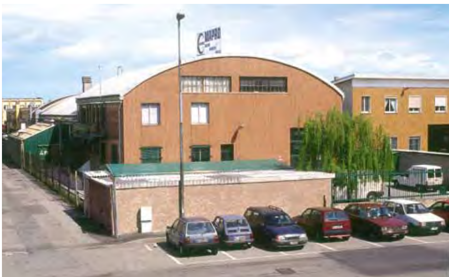
Unità Produttiva "Fermi": Compressori rotativi
